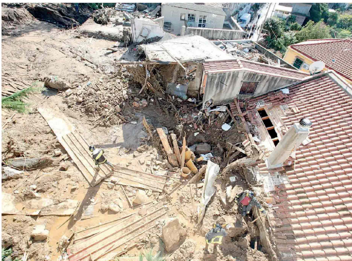
La zona di Saponara, devastata da una alluvione
